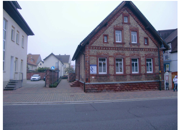
Neuer Zustand mit neuem Fußweg zu Parkplatz Holzstraße und Gehwegausbau an der Neustadter Straße
