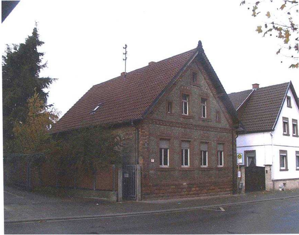
Neustadter Straße 13 alter Zustand
