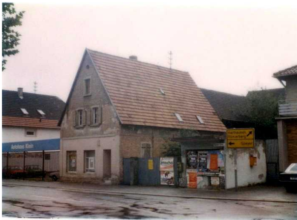
Alter Zustand Speyerer Straße 4
